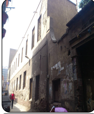
لوحة (٨) الواجهة الجنوبية الغربية لمصنع الكسوة بالخرنقش (تصوير الباحثن)
