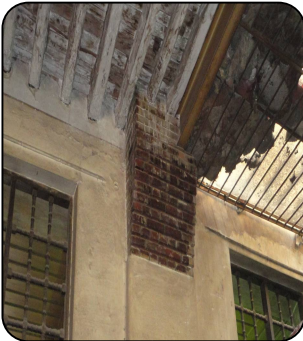
لوحة (١٥) كوابيل من لطوب الأحمر بصللة الرئيسية رقم (٣) بالدور الأرضي لمصنع الكسوة بالخرنقش (تصوير الباحثن)
