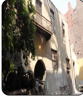
لوحة (١١) الواجهة الجنوبية الغربية لمصنع الكسوة بالخرنقش (تصوير الباحثن)
